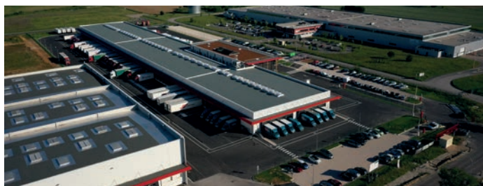
Entrepôts Seveso du Groupe Blondel à Chalon-sur-Saône (71).
